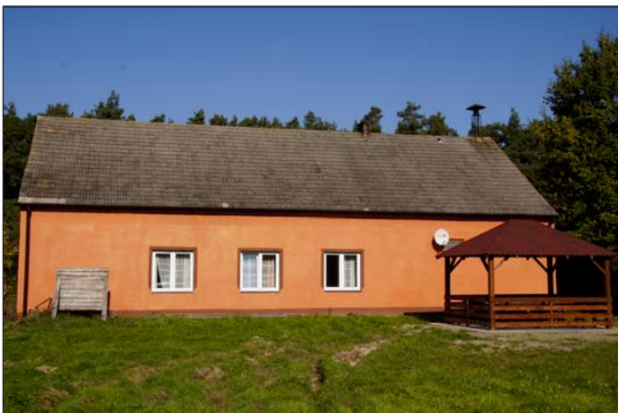
Budynek Remizy OSP z altanką
