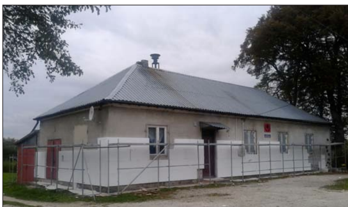
Remiza OSP Rzemienowice w trakcie remontu
