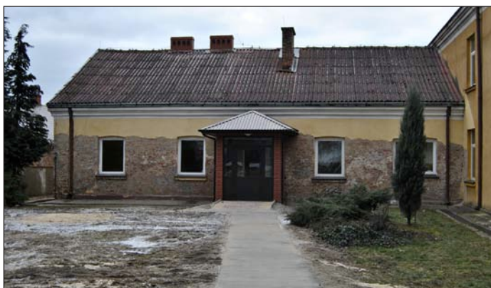
Budynek Przedszkola przed remontem
