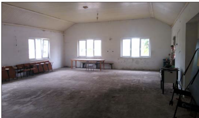
Duża Sala przed remontem
