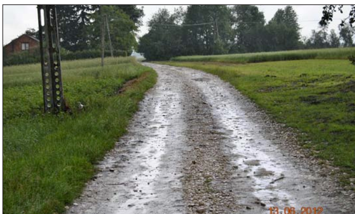
Charbinowice droga przed remontem
