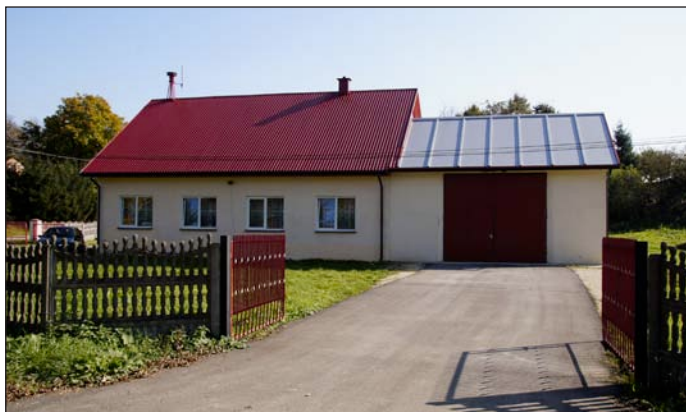
Remiza OSP z nową drogą dojazdową i po wymianie dachu
