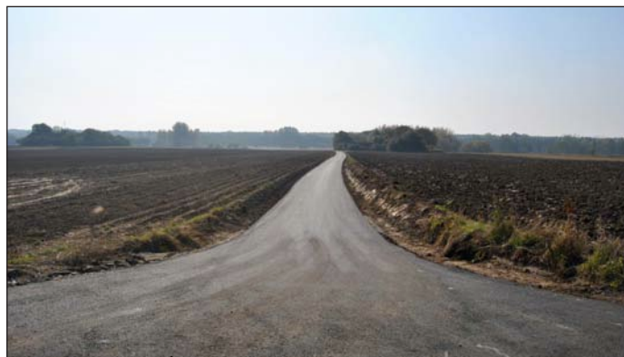
Nowa nawierzchnia asfaltowa o dł 210 mb
