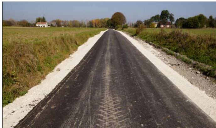
Nowa droga Senisławice - Chwalibogowice
