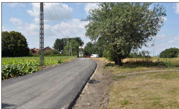
Charbinowice wyremontowana droga
