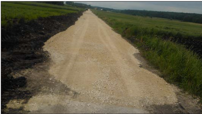
Droga w trakcie remontu
