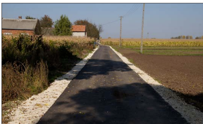
Nowa asfaltowa droga na Korej
