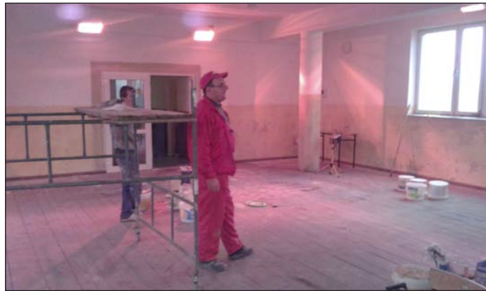
Montaż ogrzewania promiennikowego
