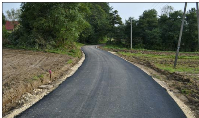
Droga po remoncie
