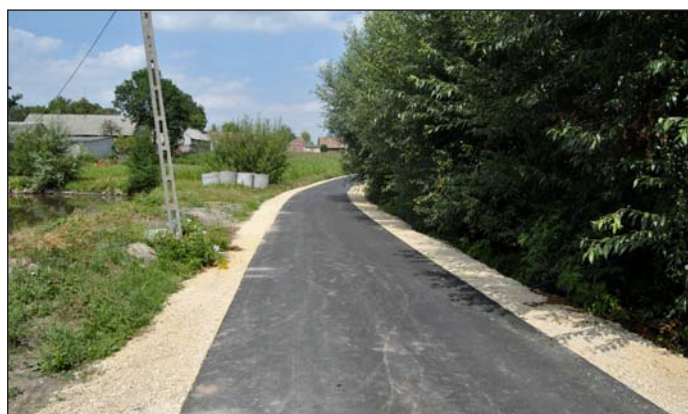
Ul. Ogrodowa po remoncie
