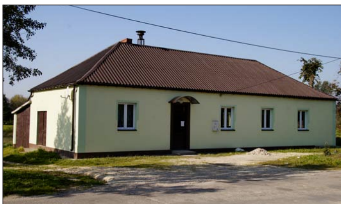
Remiza OSP Rzemienowice po remoncie
