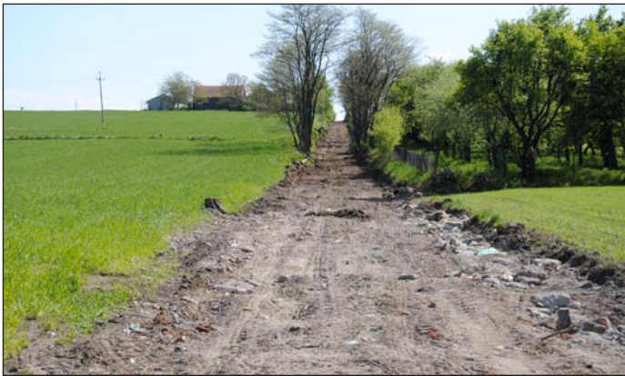
Droga Chrustowice - Kobiela przed remontem
