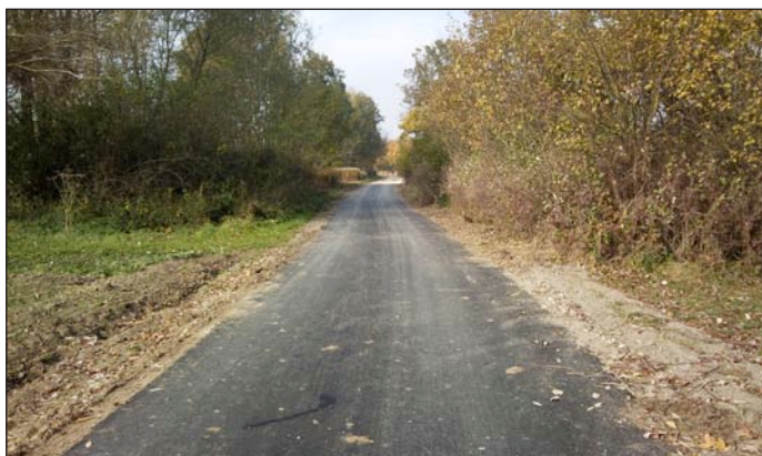
Nawierzchnia asfaltowa w Rzeczyskach
