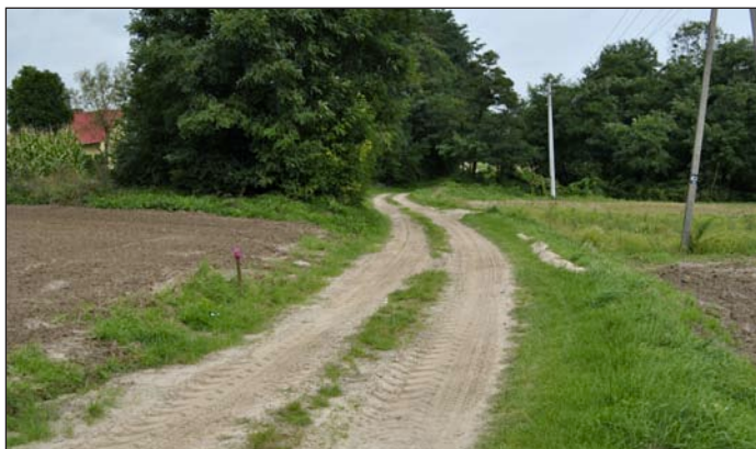
Droga przed remontem
