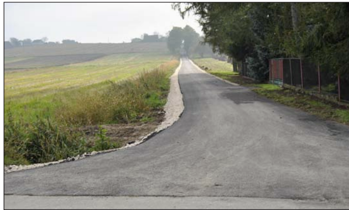
Droga Chrustowice - Kobiela po remoncie
