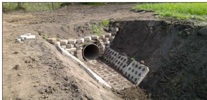
Odprowadzenie wody na Skagę
