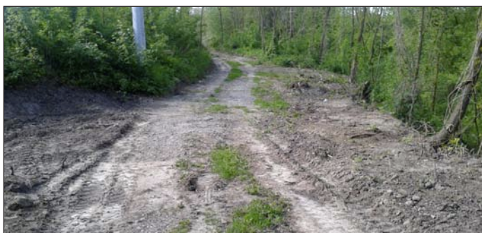
Droga w trakcie remontu
