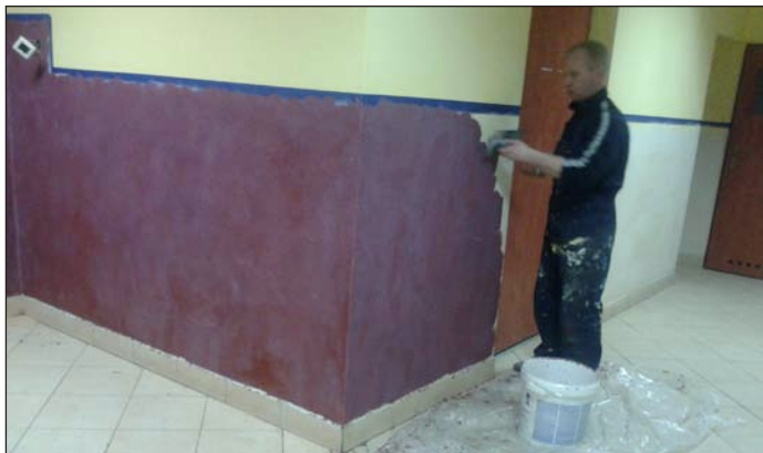
Remont w Domu Kultury
