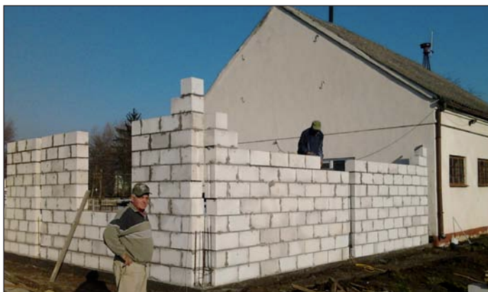
Budowa garażu przy remizie OSP Kocina
