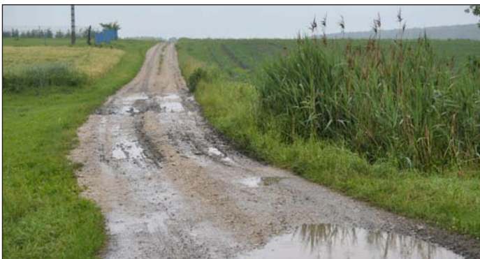
Droga Trębaczów - Rzemienowice przed remontem
