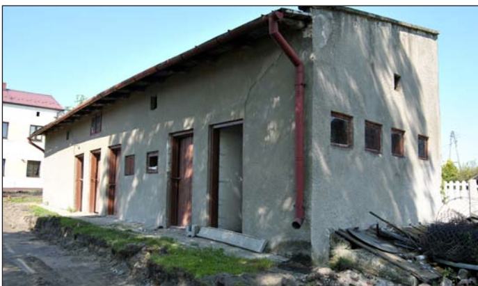
Budynek gospodarczy przy urzędzie gminy przed remontem
