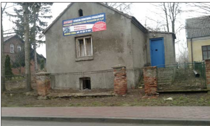
Utwardzony plac przed rozbiórką budynku
