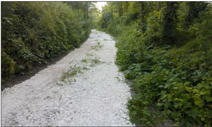
Cicha droga po remoncie - nawierzchnia tłuczniowa
