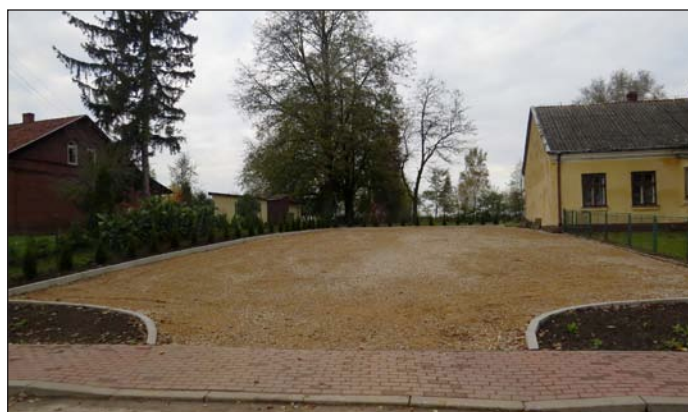
Utwardzony plac w Krzczonowie
