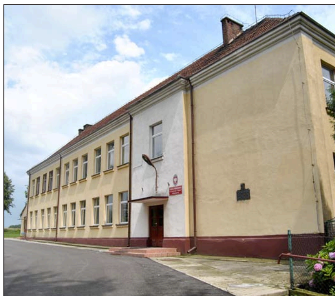
Szkoła przed termomodernizacją z wykonaną nawierzchnią asfaltową
