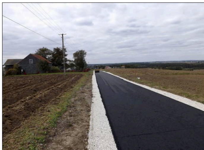
Droga przez Kobielę po remoncie
