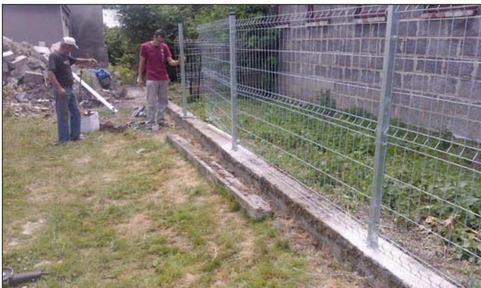
Budowa ogrodzenia przy Ośrodku Zdrowia
