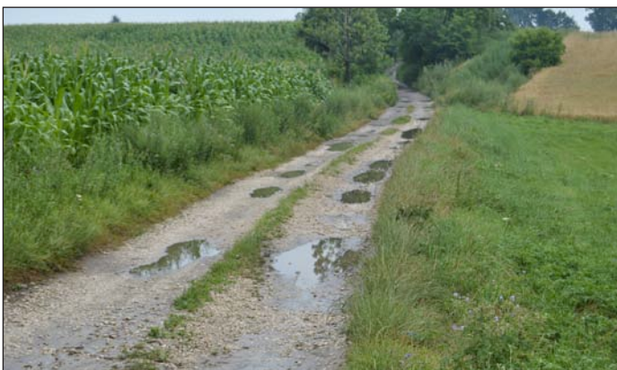
Droga Potulin - Górny Rogów przed remontem
