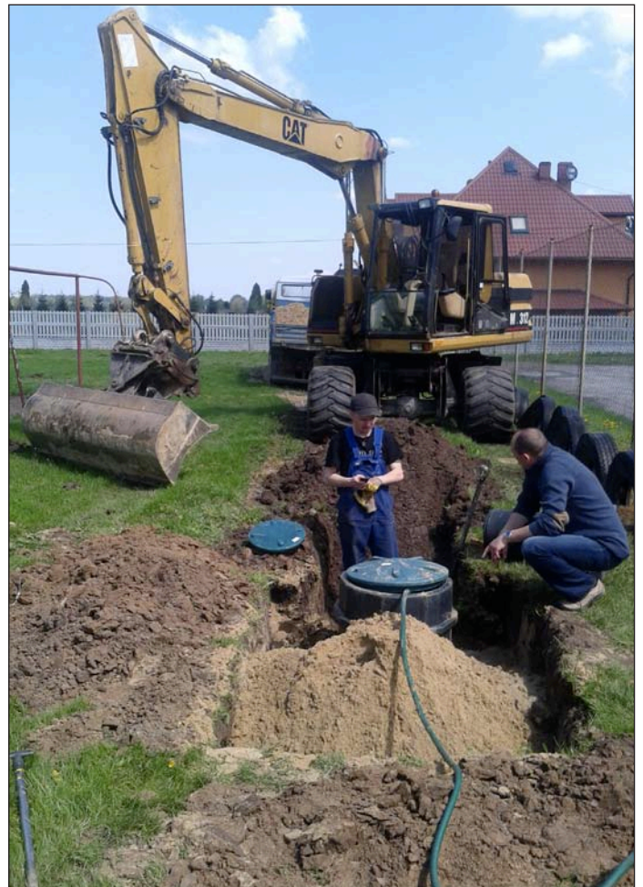
Montaż przydomowej oczyszczalni ścieków
