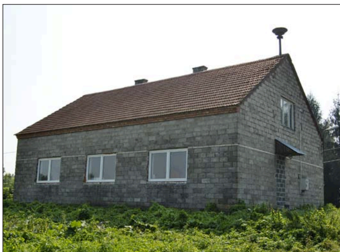
Wymienione okna w Remizie OSP Kęsów
