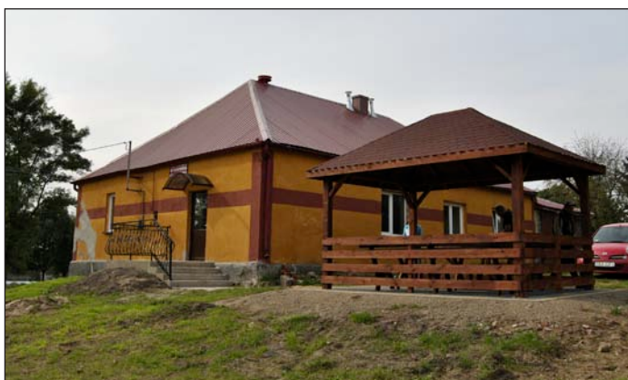
Świetlica wiejska z altaną
