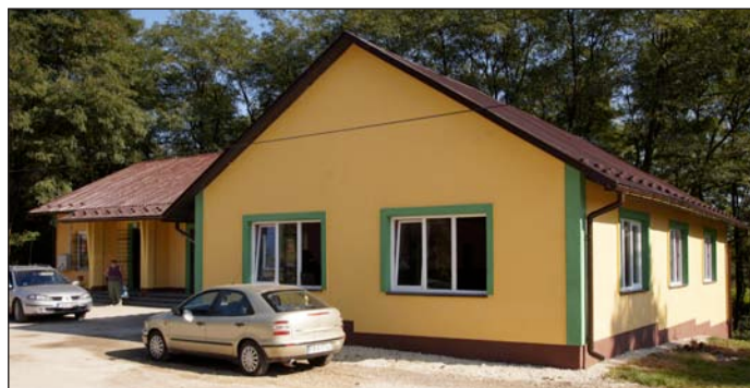
Świetlica wiejska po remoncie
