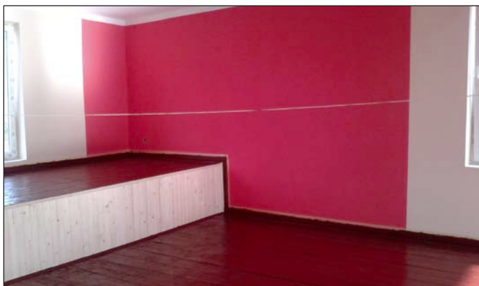
Duża sala w budynku świetlicy
