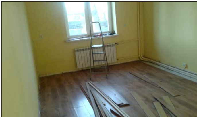
Remont pomieszczenia budynku Urzędu Gminy
