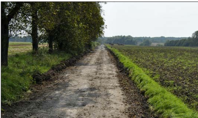
Droga Senisławice - Chwalibogowice przed remontem
